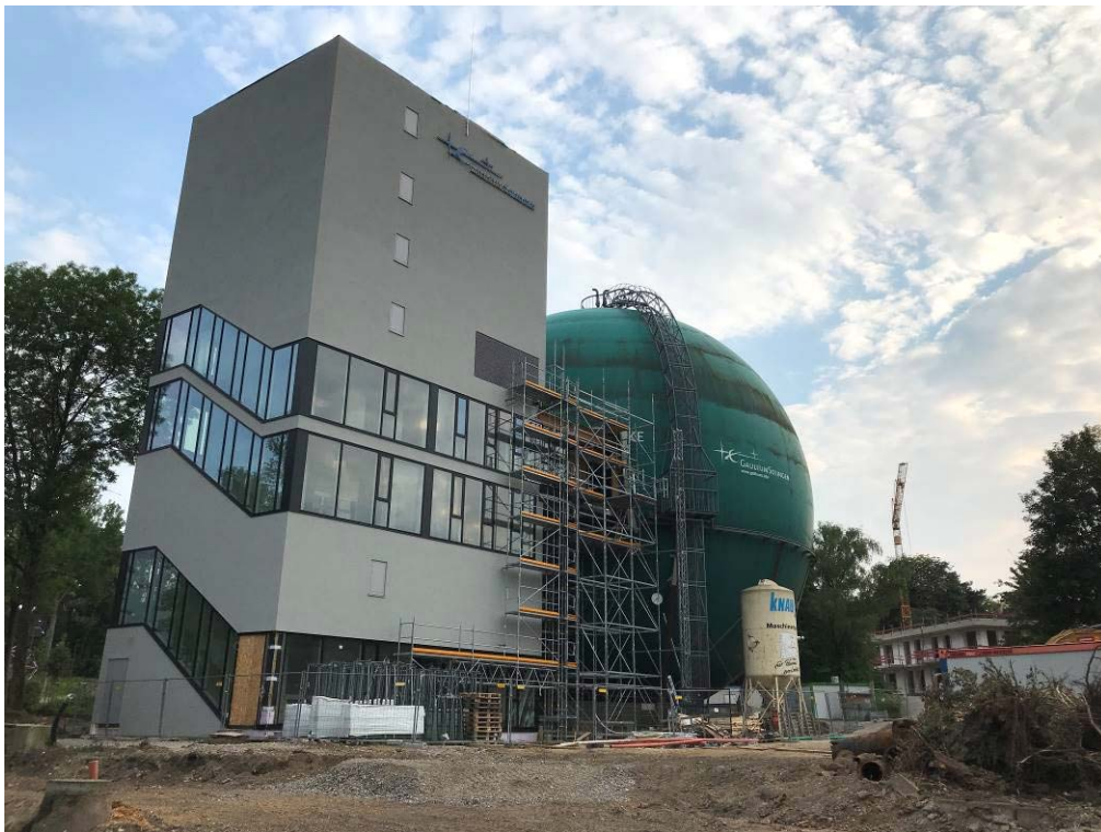
Abb.: Der Neubau neben dem Gasbehälter wird noch 2018 teilweise bezugsfertig sein.
